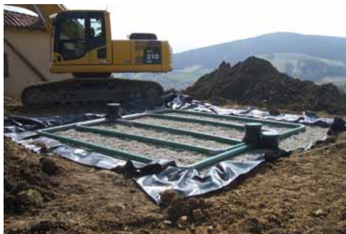
Travaux de réalisation d'un filtre à sable
