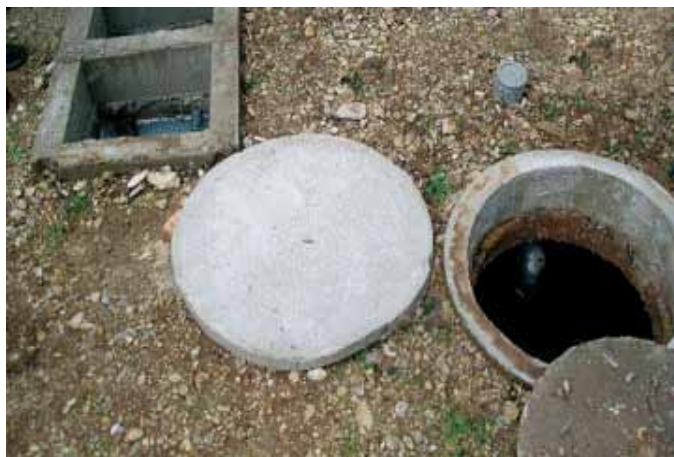
Regards de visite accessibles
