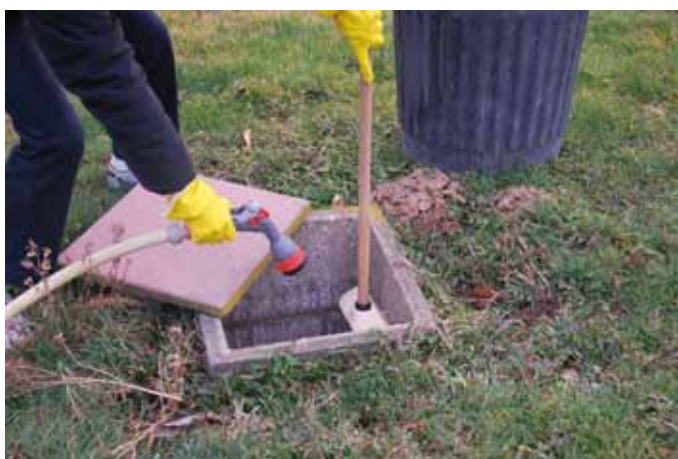
Nettoyage périodique des regards de visite
